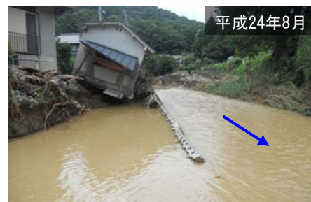
志津川の河岸欠壊(宇治市志津川)
