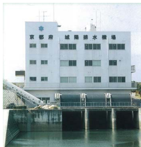
城陽排水機場
