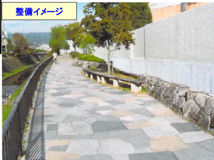
河川沿いの散策路整備
