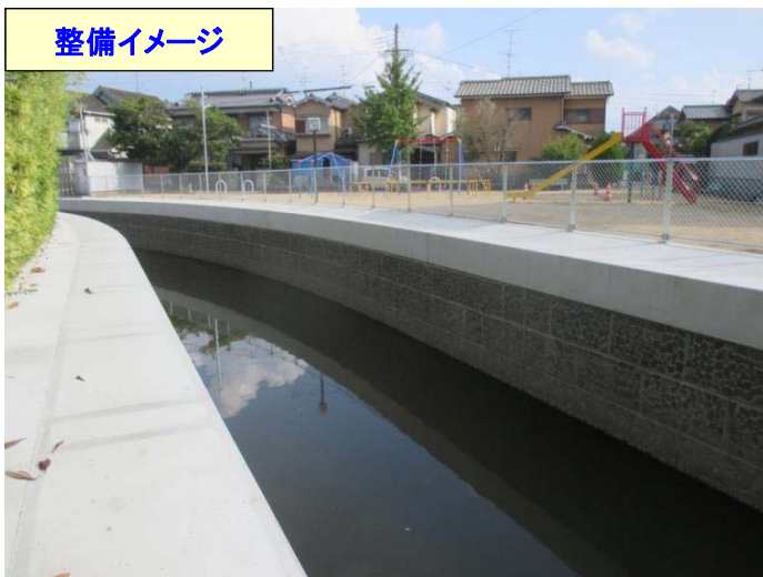
化粧パネルを貼り付けた矢板護岸
