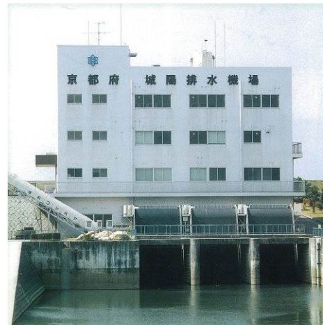
城陽排水機場
