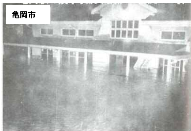
JR 亀岡駅の浸水状況 (昭和28年台風13号)※1
