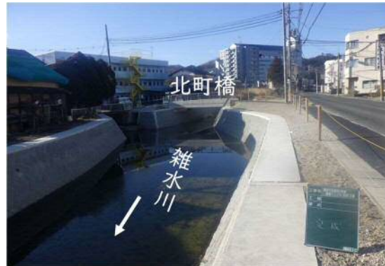
現況 (土橋上流)
