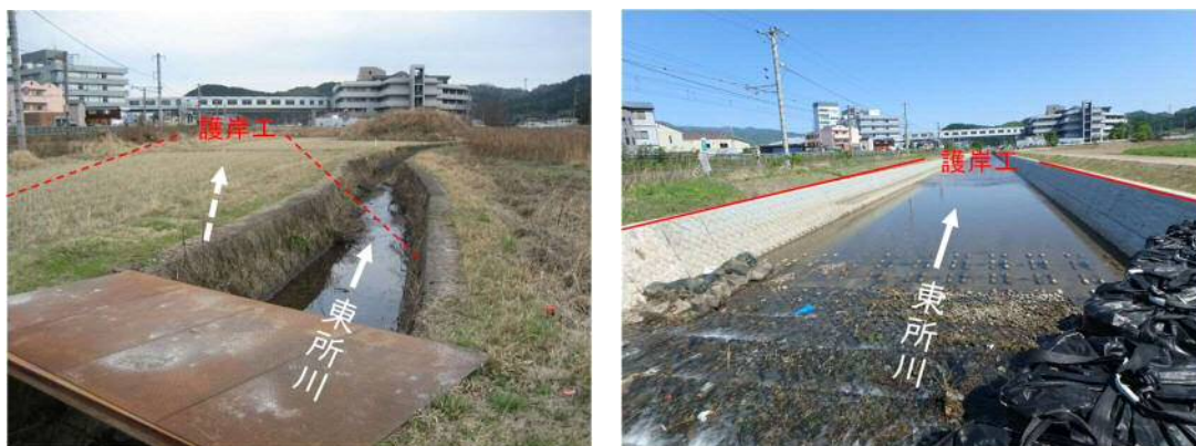
前回評価時(京都中部総合医療センター付近) 現況(京都中部総合医療センター付近)
