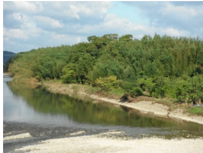
河道内樹木繁茂状況
