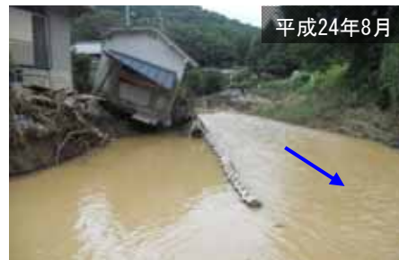
志津川の河岸欠壊(宇治市志津川)
