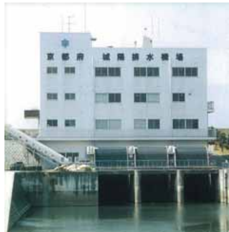
城陽排水機場
