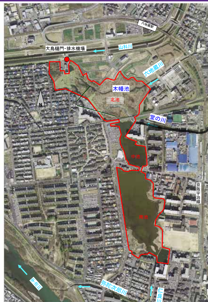
堂の川(木幡池)の整備区間
