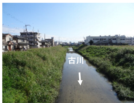
暫定完成（久御山町・城陽市境付近）
