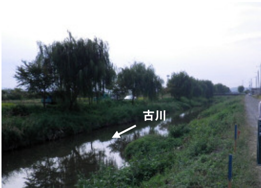
改修前（国道 24 号下流）
