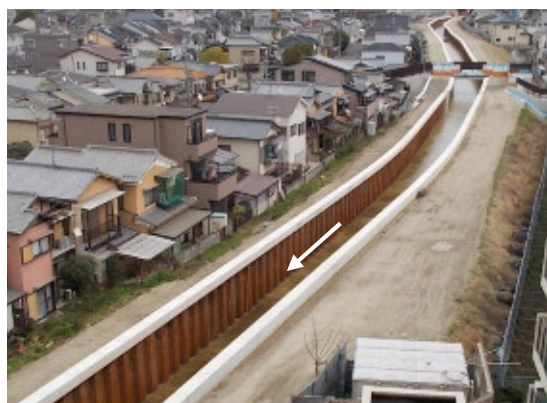
整備後（雲雀橋上流）
