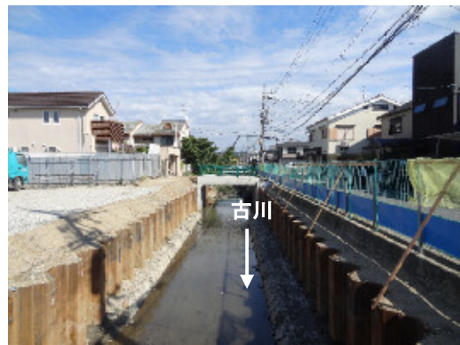
改修中（今池川合流点上流）
