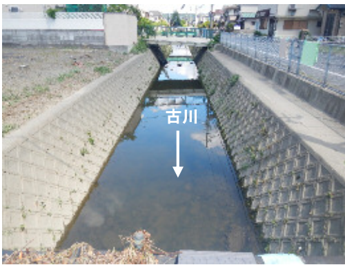
改修前（今池川合流点上流）
