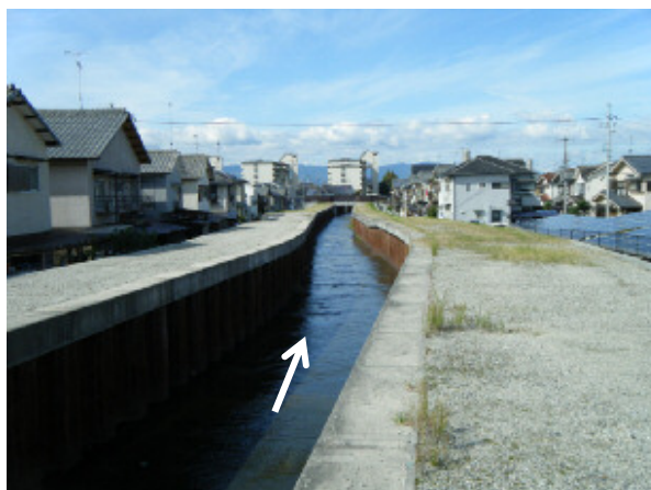
整備後（決壊地点）
