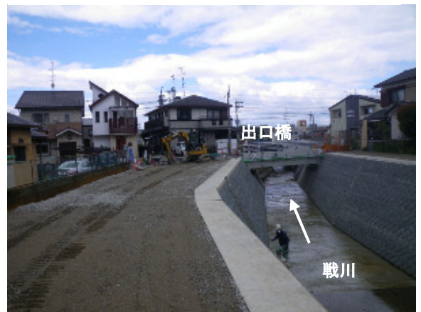
整備後（第一出口橋）
