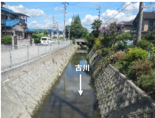
改修前（一級起点付近）
