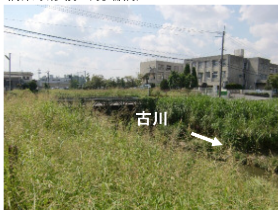
橋梁改修前（境端橋）
