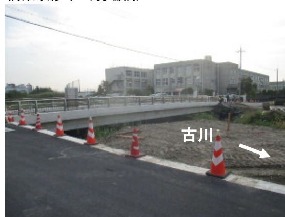
橋梁改修中（境端橋）
