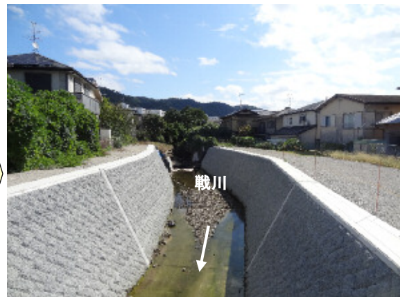
整備後（第一出口橋上流の状況）
