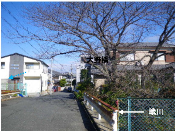
整備前（第一出口橋）
