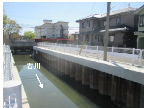
改修中（一級起点付近）
