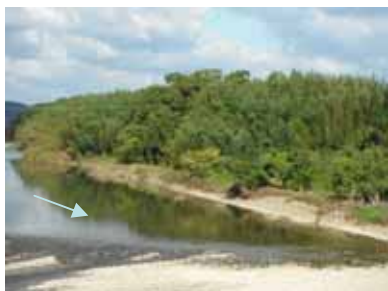
河道内の樹木繁茂状況(桂川)
