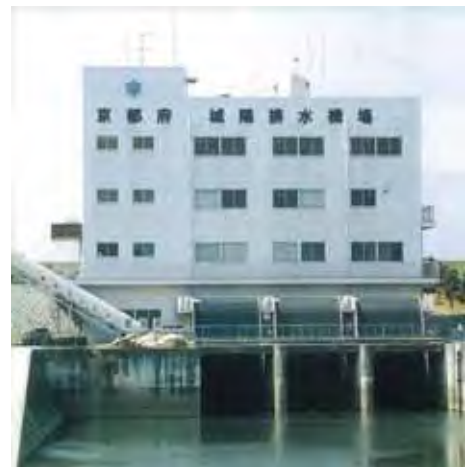
城陽排水機場
