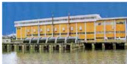
久御山排水機場(国土交通省管理) 出典:近畿地方整備局HP
