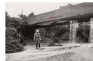
弥陀次郎川の天井川区間の災害(昭和42年7月洪水) 漏水により盛土が流出し、河床に穴が空いた(水路橋ではない)
