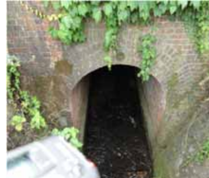
旧安祥寺川の未改修区間 (JR東海道線交差部)
