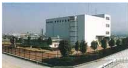
城陽排水機場(京都府管理)
