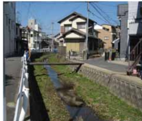
東高瀬川の未改修区間
