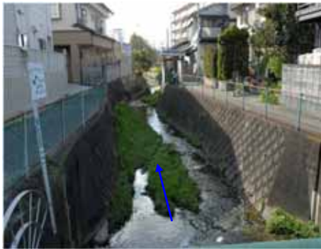
七瀬川の未改修区間(京阪線下流)
