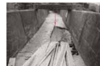
弥陀次郎川の天井川区間の災害(昭和42年7月洪水) 漏水により盛土が流出し、河床に穴が空いた(水路橋ではない)
