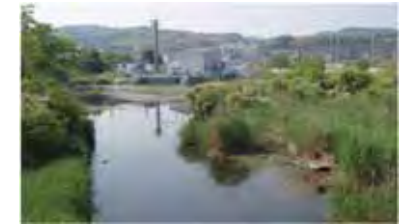
木幡池の状況 (大島排水機場付近)
