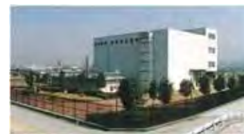
城陽排水機場(京都府管理)
