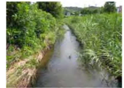
田原川(植生に覆われた状況)
