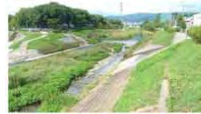
山科川 両岸ともコンクリート護岸で、落差工下流に中洲が形成され、水際の植生が発達している。
