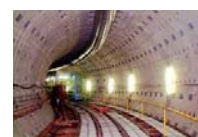
いろは呑龍トンネル(第3号)
