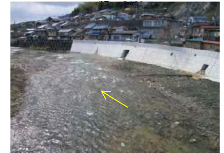
【和東川護岸補強】
