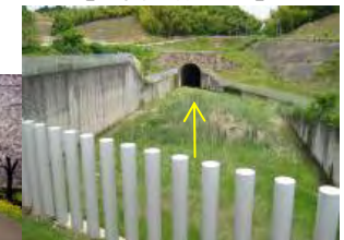
【井関川放水路】
