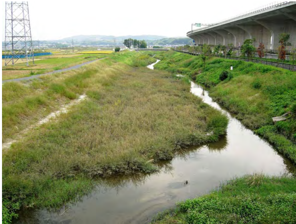
防賀川(八丁南橋上流付近)
