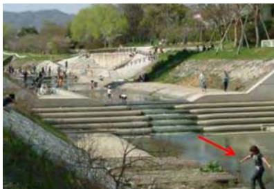
小畑川(落差工)
