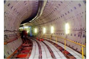
いろは呑龍トンネル
