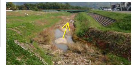
【木津川合流点付近(煤谷川)】
