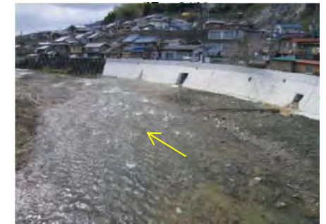
【和束川護岸補強】
