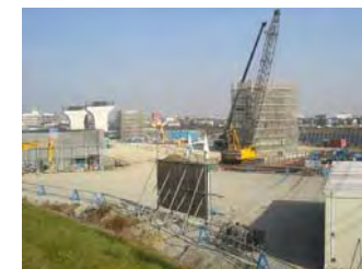
にそと建設現場（小泉川付近）
