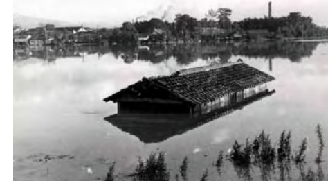
昭和28年台風13号(長岡京市)
