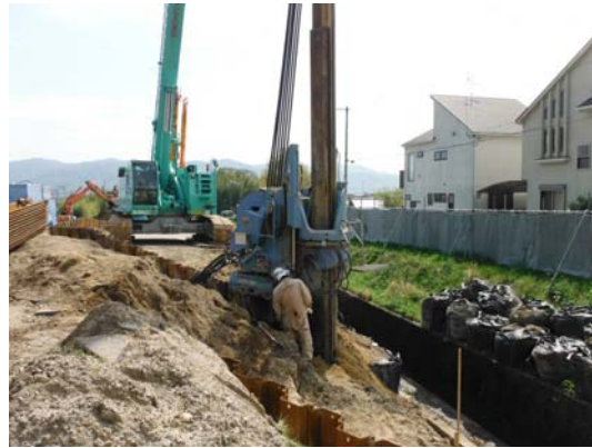
図- 36 近接家屋への騒音・振動対策の実施 (パイルオガ-併用圧入工法) (防賀川)
