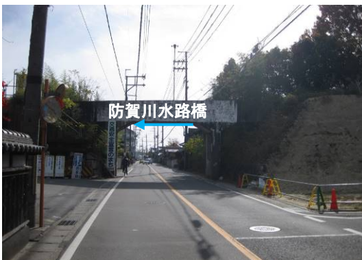
整備前 (旧府道八幡木津線交差部)
