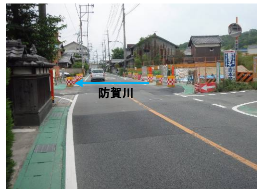
整備後 (旧府道八幡木津線交差部)
