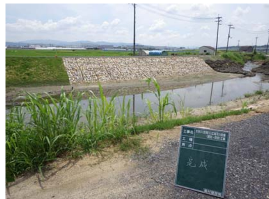
図- 35 多自然護岸整備の実施（左：施工前、右：施工後）（防賀川）
