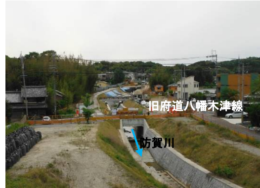
整備後（旧府道八幡木津線上流）
