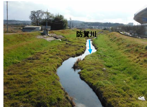
整備後 (第二京阪併走区間起点付近)
