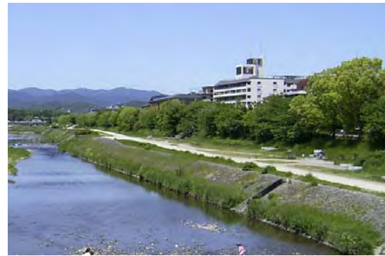
護岸の写真(荒神橋付近)
