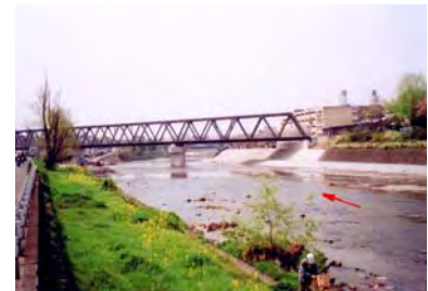
J R 奈良線橋梁改築
