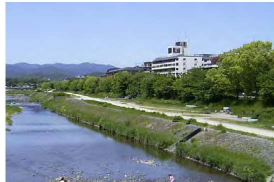
護岸の写真(荒神橋付近)
