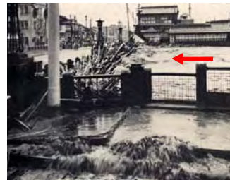
四条大橋付近のはん濫状況
