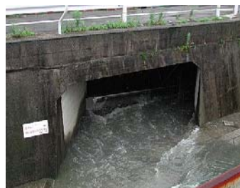
ゴミの流出を防止する ろ過スクリーンの設置（西高瀬川）（京都市上下水道局HPより）
