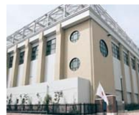
公共施設での雨水利用施設その2 (京都府立山城高等学校)
