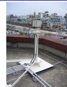
鴨川沿川の防災カメラ
