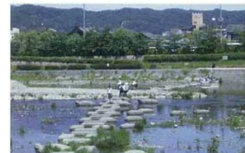
賀茂大橋上流の飛び石
