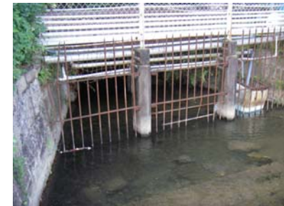
高瀬川の取水箇所
