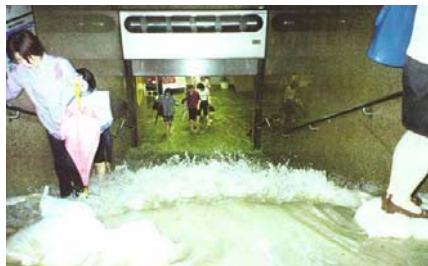
地下鉄博多駅入口より流入する氾濫水
