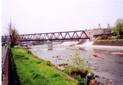
「JR奈良線橋梁改築」
