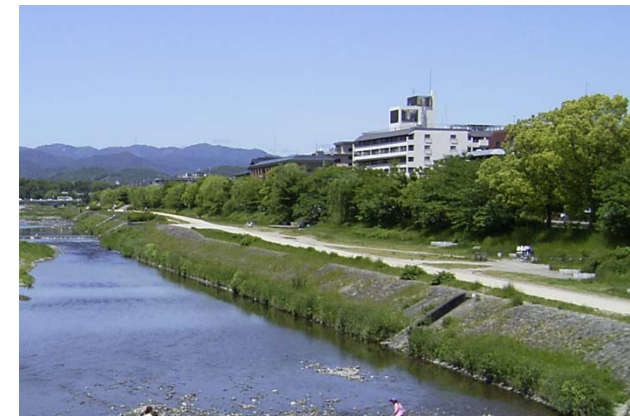
護岸の写真（荒神橋付近）
