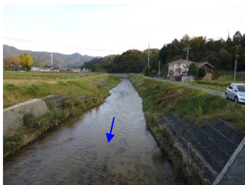
八ツ橋上流の改修状況
