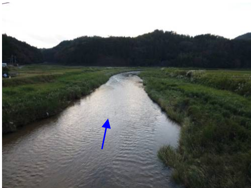
三原川合流点上流の改修状況
