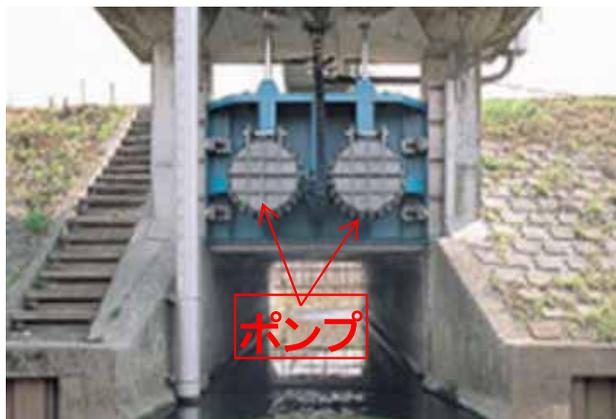
ゲートポンプとは、樋門ゲートと水中ポンプを一体化した強制排水設備のこと
