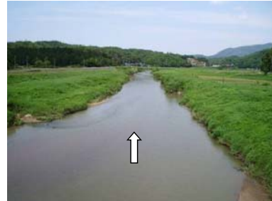
②国久橋下流
