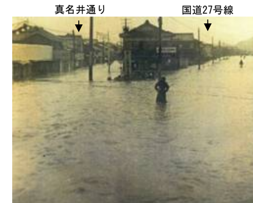
国道27号線西舞鶴駅前 昭和28年水害(高野川)
