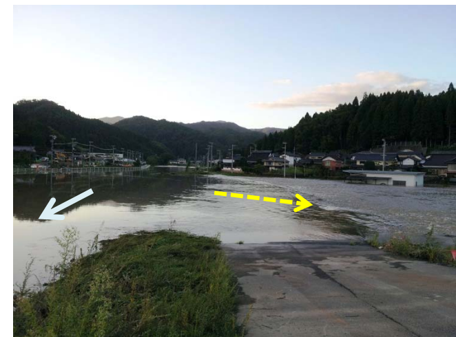
宮川(福知山市): 由良川水位の影響を受け左岸堤から越水
