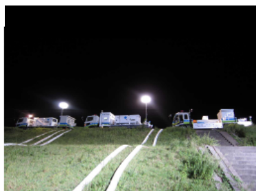
福知山市上荒河 （弘法川樋門）
