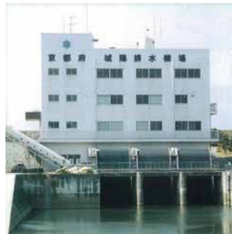
城陽排水機場
