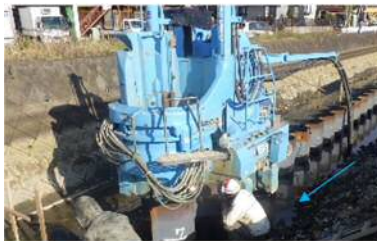
根継矢板の施工状況
