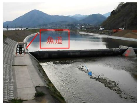
図15 井堰に設置された魚道の例
