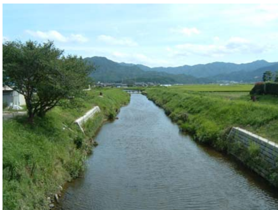
川上谷川未改修区間（橋爪橋から上流）
