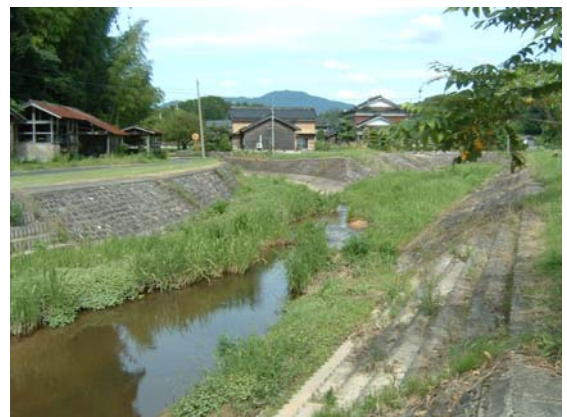
永留川（大門橋上流）
