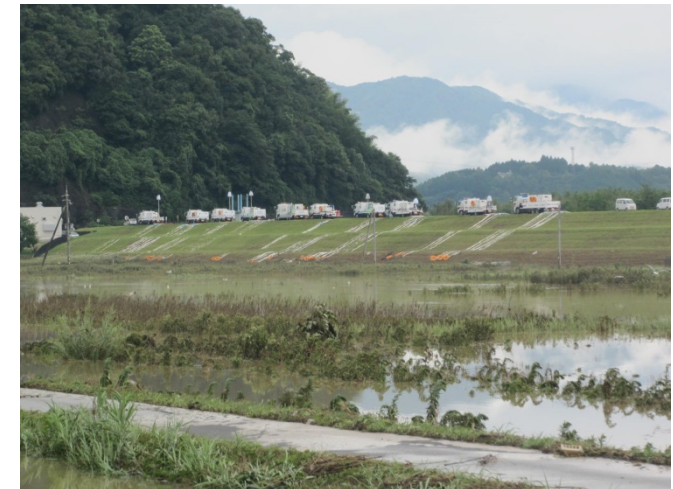
近畿地方整備局の排水ポンプ車稼働状況 (H30年7月豪雨・福知山市荒河排水機)
