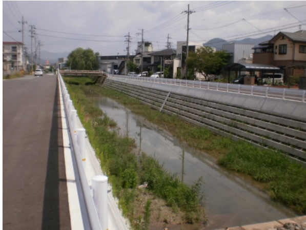
低水路の保全・環境配慮型護岸の採用
