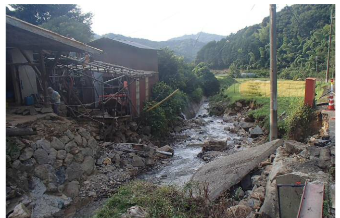
二級河川狩場川被災状況（宮津市新宮地区）
