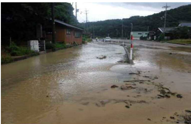
国道178号道路冠水状況（京丹後市網野町木津地区）
