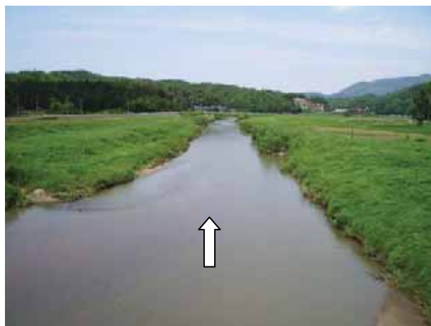
②国久橋下流
