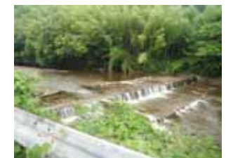
落差工（池内川）
