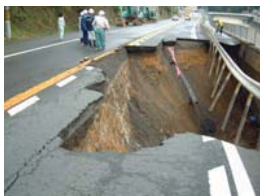
国道27号(真倉地先) ※1
