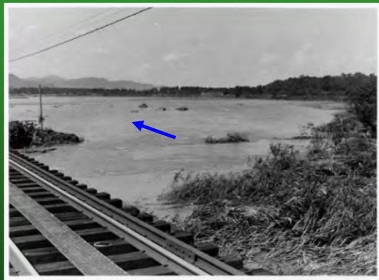
S47.9 台風20号被災状況
