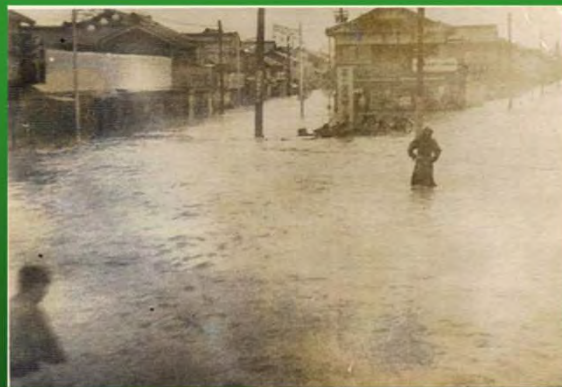
S28.9 台風13号被災状況
