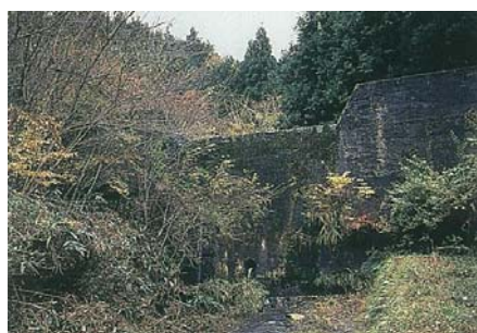
図 1-5 周辺の景観にとけ込むえん堤 (雲原砂防施設群)
