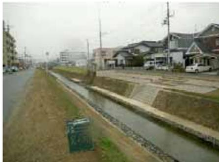
石積護岸の改修(府内の間伐材を利用した杭柵による根固め工)・親水施設整備(護岸法面のスロープ化、遊歩道、階段、飛石設置)を行っています
