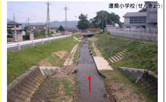
福知山市石原地区を流れる大谷川の水辺環境整備事業では、計画段階で小学生の意見を聞き、また間伐材を用いた木工沈床や杭柵工を用いることにより、環境に配慮し、生態系の保全を図っていくこととしています。
