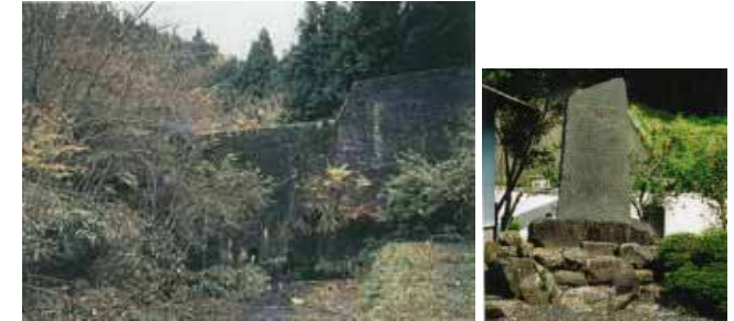
周辺の景観にとけ込むえん堤
