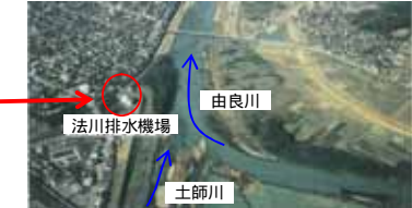
土師川合流点と法川排水機場 3
