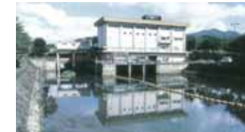
法川排水機場 (平成 13 年完成) 3
