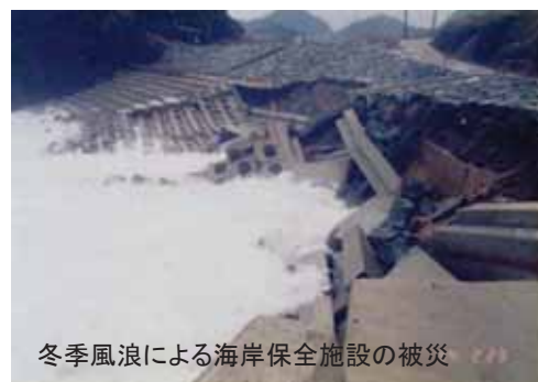
図 1-3-1 冬季波浪による海岸保全施設の被災
