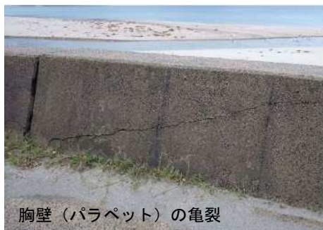
図 1-3-7 護岸の老朽化
