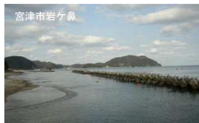
図 1-5-5 整備された海岸保全施設
