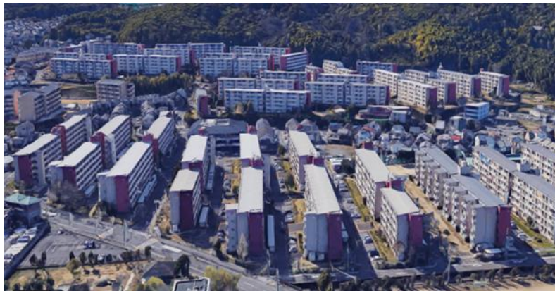
{ 小栗栖西団地: 写真奥が山手(第1棟～第24棟)、 手前が平地(第25棟～第41棟) }
