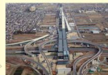
整備が進む新名神高速道路 城陽JCT・IC付近（NEXCO西日本提供）
