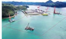
舞鶴国際ふ頭II期整備施工箇所
