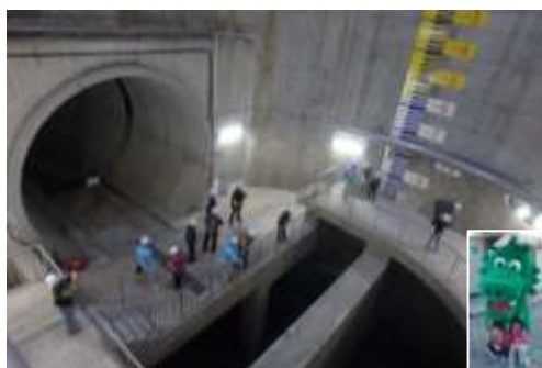
乙訓ポンプ場
