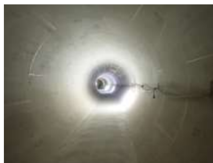
南幹線管渠シールド工事完成
