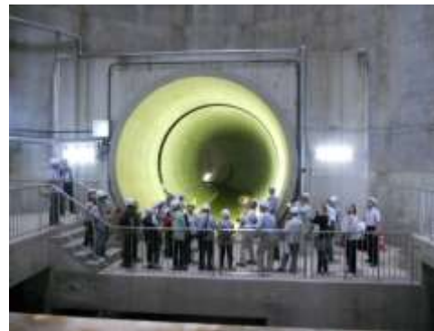
雨水北幹線第3号管渠
