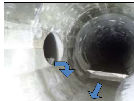
③接続管きよ(長岡京市勝竜寺)
