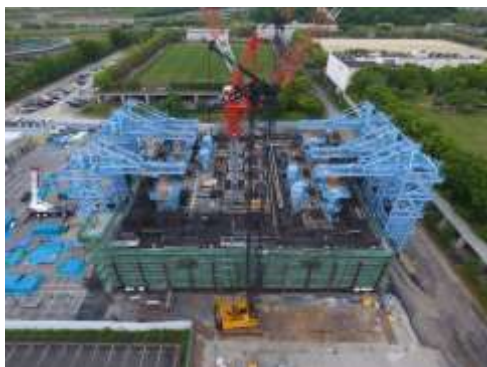
呑龍ポンプ場 (洛西浄化センター内)
