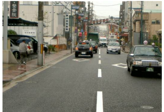
雨水を浸透させる舗装 施工後
