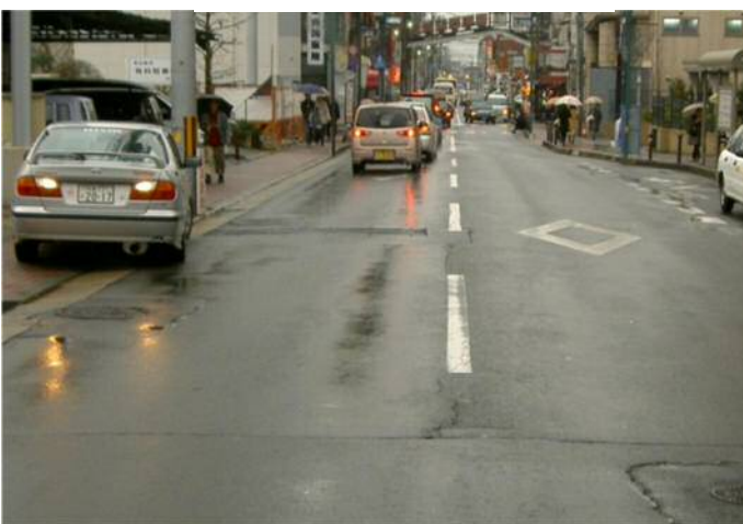
雨水を浸透させる舗装 施工前
