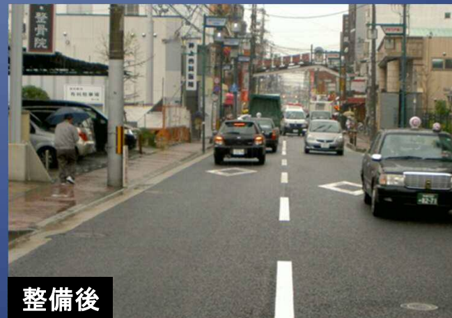
雨水を浸透させる舗装 施工後
