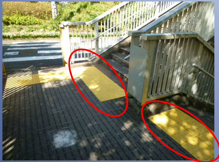
横断歩道橋の昇降口
