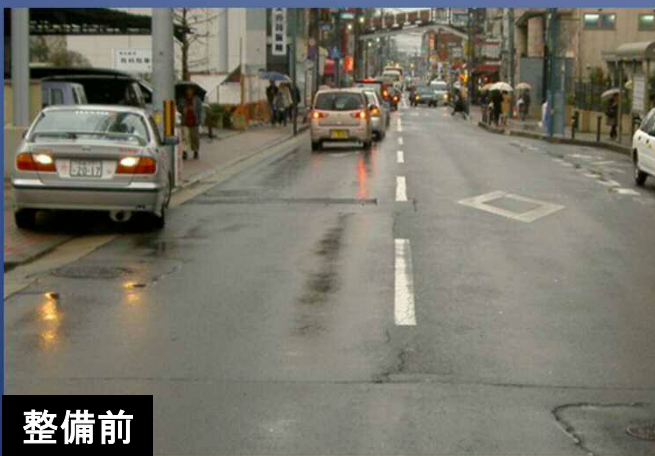
雨水を浸透させる舗装 施工前
