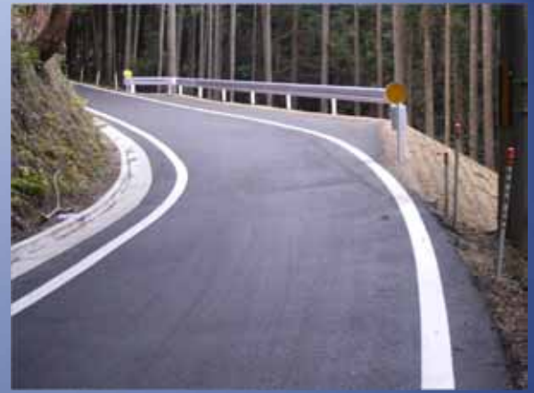
1.5車線の整備後
