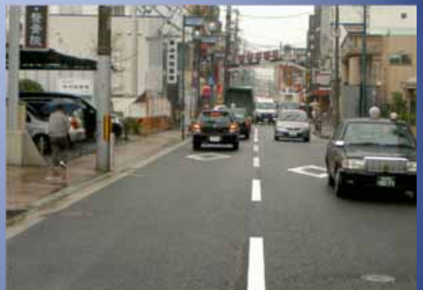
排水性舗装 施工後（雨天時）
