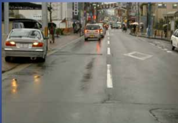
排水性舗装 施工前（雨天時）
